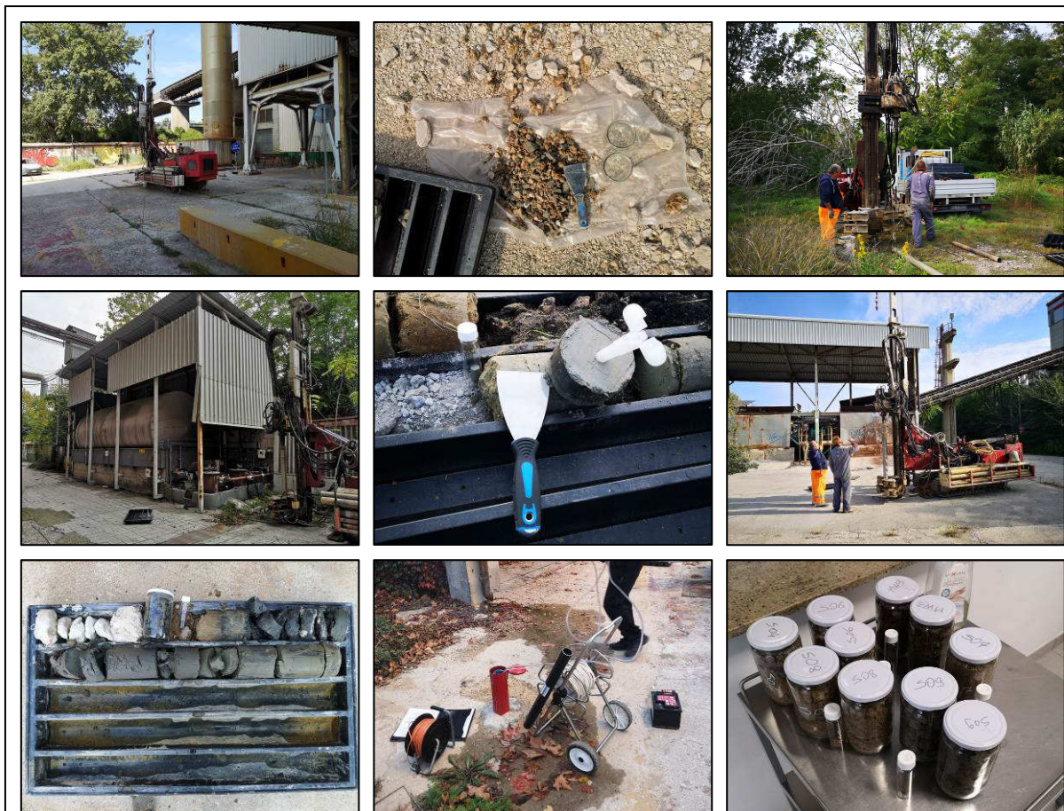
Esecuzione dei carotaggi ambientali, realizzazione di piezometri, spurghi e campionamenti.
